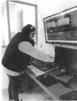
Limpeza de switcher
