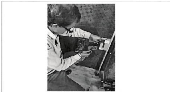
Medición de tierra en contactos
