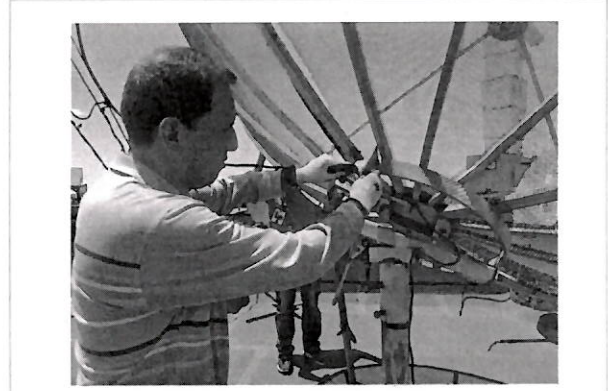
Ajuste de ejes de la antena
