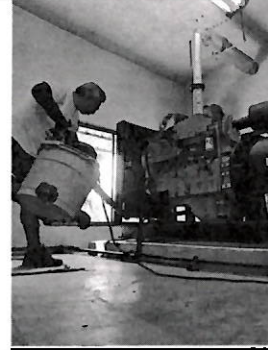
Se realiza mantenimiento de Planta de emergencia.
