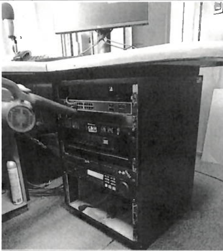
Limpieza de equipos de transmisión y rack de equipos
