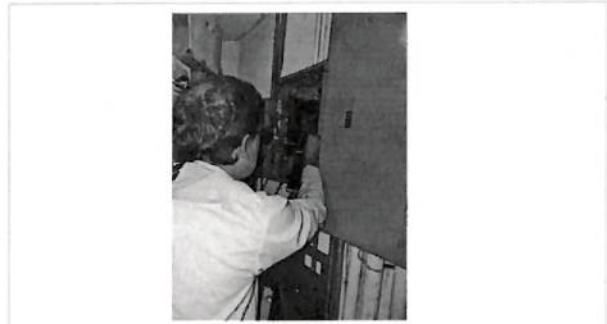
Ajuste de tornillería de los "breaks"
