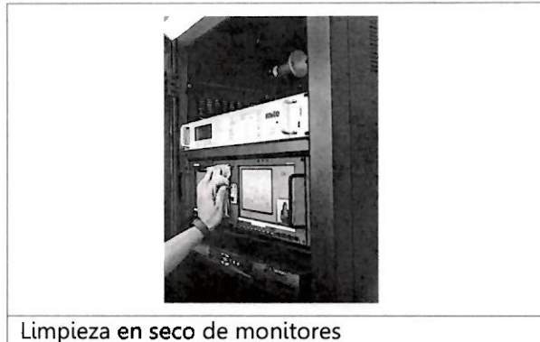
Limpeza en seco de monitores
