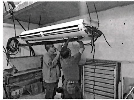
Se Realizó un mantenimiento especializado al sistema de climatización.
