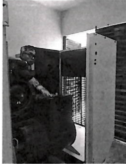
Se realiza limpieza de Plantas Eléctricas así como su revisión de baterías (fallo).
